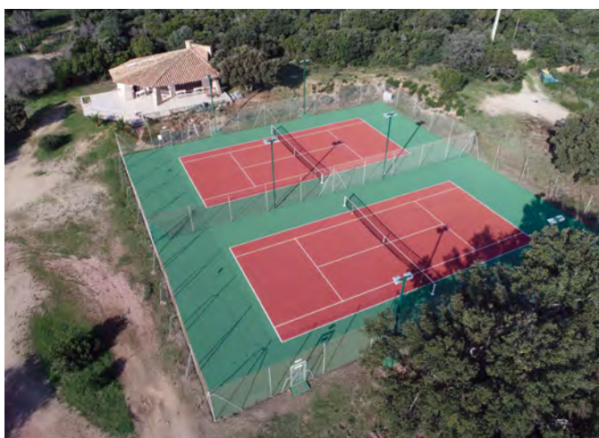
Rénovation à neuf, durant les vacances de la Toussaint, des terrains de tennis municipaux.
